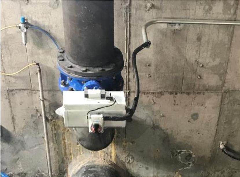
污水处理厂中用于打开球阀的执行机构，现场发现驱动头在运行过程中，总是有卡顿，且运行比较慢，能听到里面有类似进气节流出现一顿一顿的异响。
