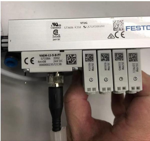
首先需要给阀岛供 24V 电压，电压分为逻辑电压和负载电压。CPX-E-PN 模块最下方是逻辑电压，分别有两组 24V 和 0V。0 和 1、2 和 3 是分别相通的，所有实际只需要接其中一组（0 和 2 或者 1 和 3 二组选一）。
